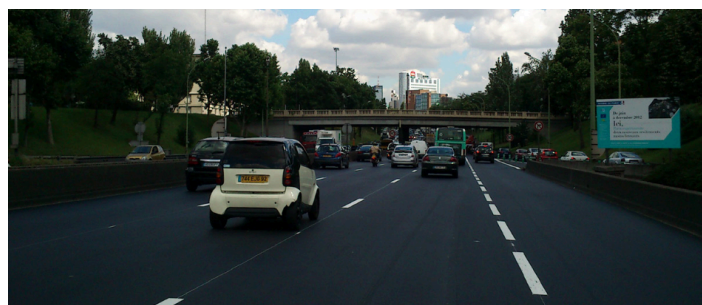
Expérimentation de revêtement absorbant le bruit sur le périphérique parisien - Francilophone n°27 Bruitparif
